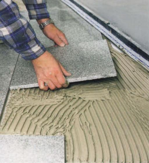
Le mortier à base de trass contient une grande quantité de trass qui empêche l'eau de pénétrer dans la pierre naturelle et d'y causer des dégâts.
